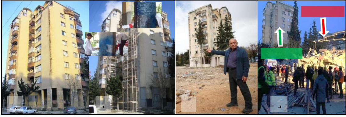
Görsel 1. a) Binanın güçlendirme önce ve b) esnasında hali (URL 4). c) Deprem sonrası bina ve binanın çevresi hali (URL 5) d) Güçlendirilmiş binanın ve yandaki aynı mimari yapıya sahip güçlendirilmemiş bina arasındaki etkilenme farkları (URL 6)
