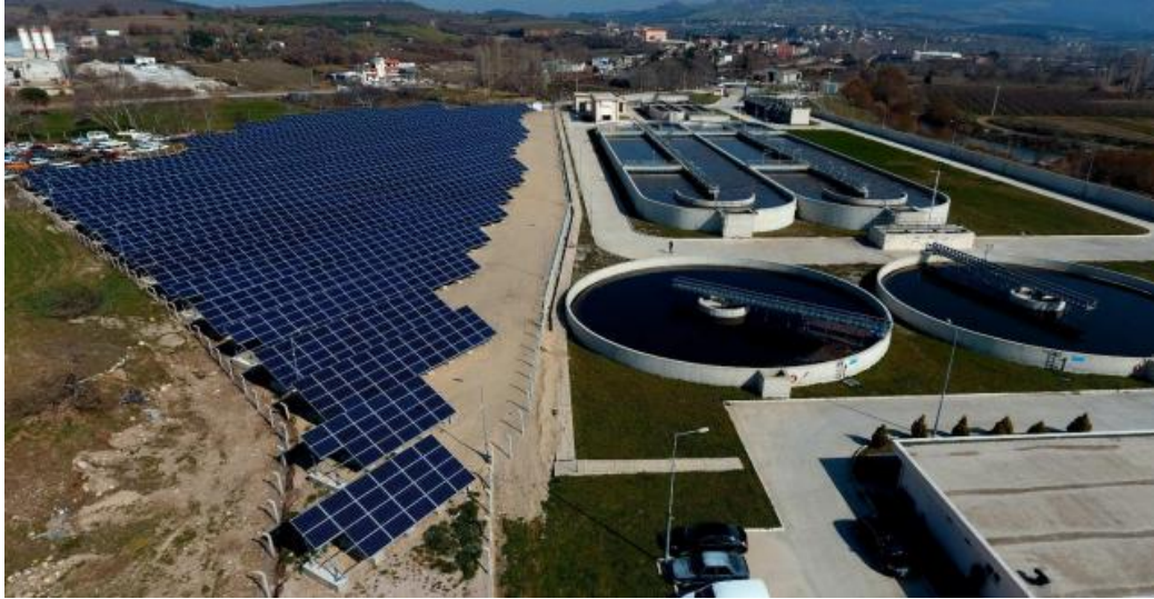
Görsel 23. Çanakkale Belediyesi Atık Su Arıtma Tesisi GES
