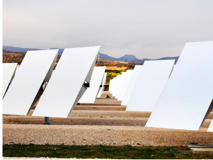
Görsel 7. Mersin Güneş Kulesi Heliostatlar
