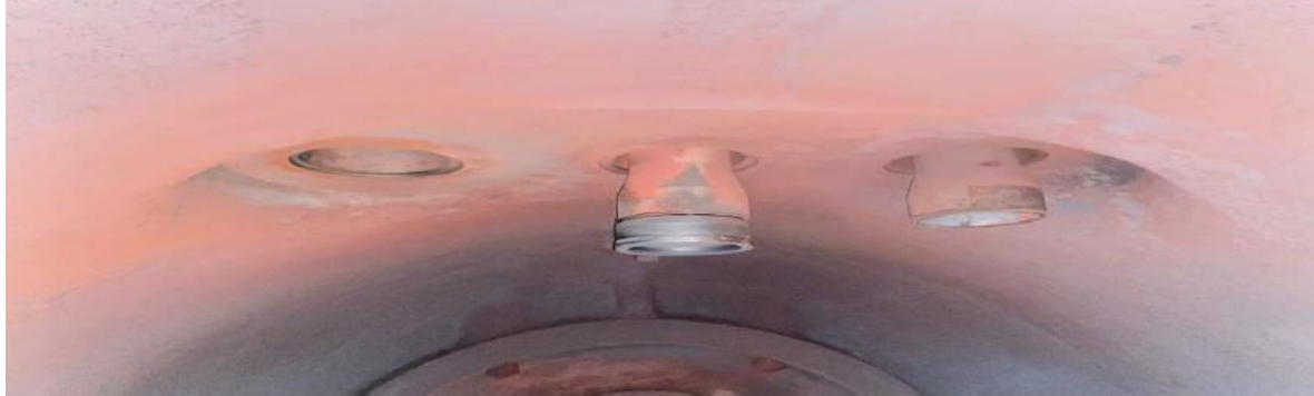
Görsel 2. Seyitömer TS, 3. Ünite Yüksek Basınç Türbini Üst Girişi Anabuhar Bağlantı Boruları
