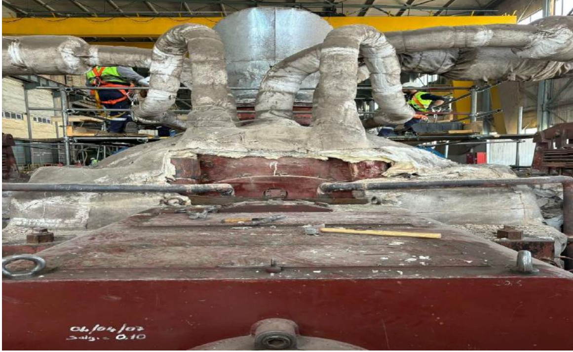
Görsel 2. Seyitömer TS, 3. Ünite Yüksek Basınç Türbini Üst Girişi Anabuhar Bağlantı Boruları
